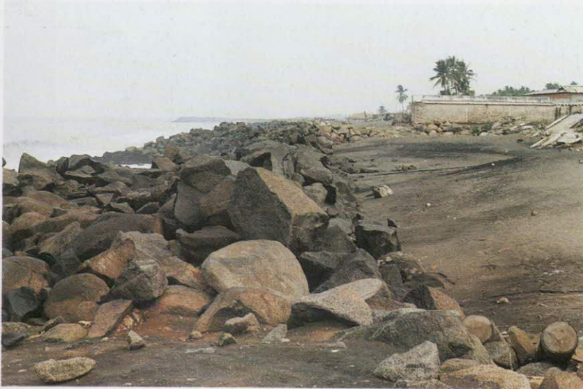
2. Frente a las palapas destruidas que se observan en la fotografía anterior, la imagen de lo que fue la playa de Puerto Madero, ahora cubierta por enormes piedras colocadas sobre ella para "proteger" de la embestida del oleaje al resto de las construcciones de casas-habitación vecinas.
