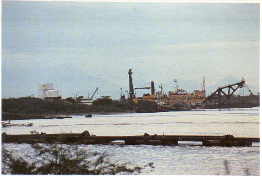
11. Vista de las plumas y de embarcaciones de dragado del muelle de carga de Puerto Madero. A la izquierda de la fotografía, algunas de las instalaciones de Pescado de Chiapas, S.A.
