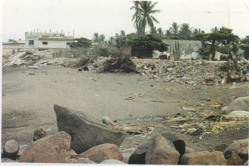
1. Ruinas de las palapas-restaurantes frente a la playa de Puerto Madero, Chiapas. La destrucción del cordón de playa litoral frente al poblado se debió al cambio de dirección de las corrientes marinas provocado por la construcción, en 1988 y 1989, de las obras de las escolleras del puerto de atraque situado a varios kilómetros de distancia.
