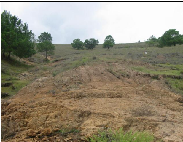
Erosión fuerte laminar
